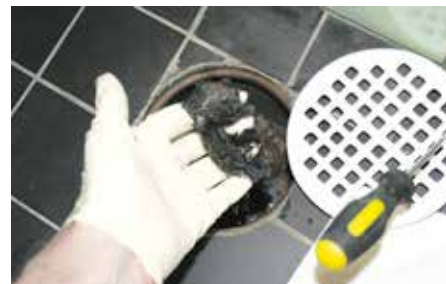
△ Lattiaaivon puhdistus on osa sekä asumisaikaista että muuttosiivousta. Yleensä siihen on aihetta.
